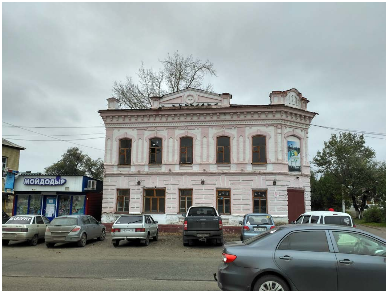
ул. Ленина, д.3, г. Мариинск - до реставрации
